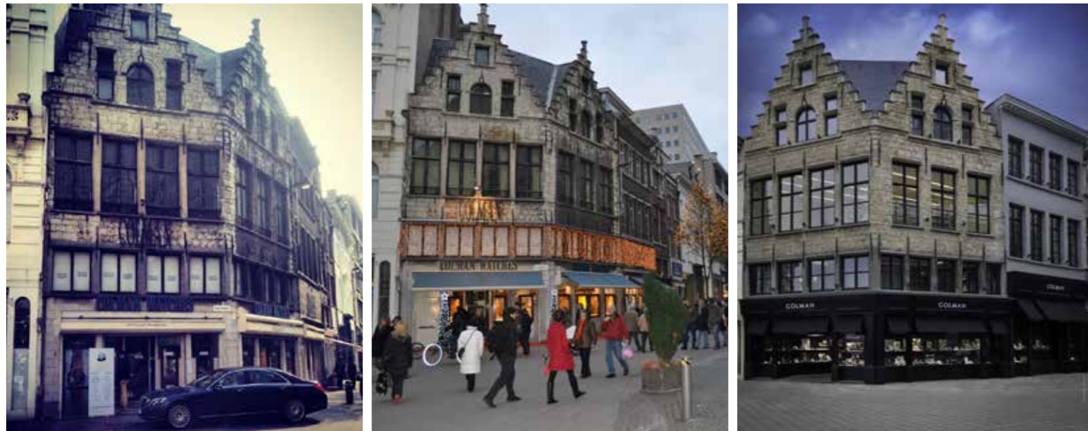
Van links naar rechts: oude gevel - constructie / werken - nieuwe gevel De gauche à droite : ancienne façade - chantier/travaux - nouvelle façade
